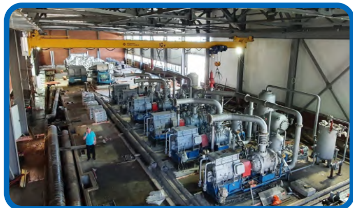
Рис. 3. Установленные на фундаменты установки Каскад-110/30. Fig. 3. KASKAD-110/30 units installed on the foundation.
