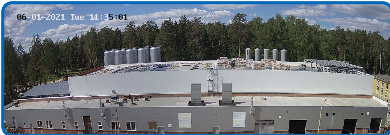
Рис. 1. Криогенно-компрессорная станция, общий вид. Fig. 1. Cryogenic compressor station, general view.
