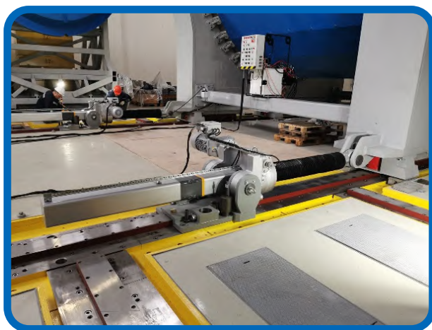
Рис. 1. Монтаж системы перемещения магнитопровода. Слева: основные штоки с рабочим усилием до 70 тонн, справа: штоки с рабочим усилием до 5 тонн для перемещения транспортной опоры полюсов.
