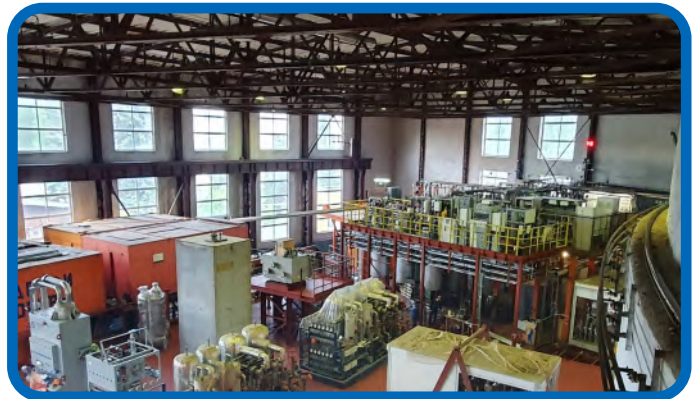
Рис. 5. Оборудование азотной системы: ожижитель и реконденсатор азота.
