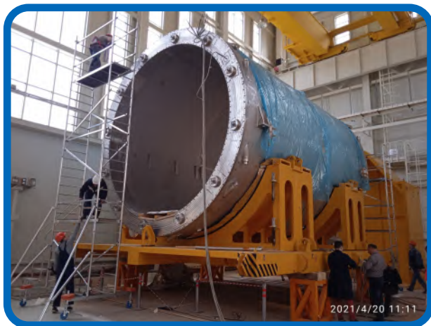
Рис. 2. Подготовка и проведение слаботочного электрического теста.
