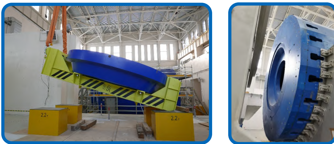
Рис. 2. Слева: кантовка полюса с помощью спроектированной в КО ЛФВЭ траверсы, справа: полюс установлен в опорное кольцо магнитопровода.
