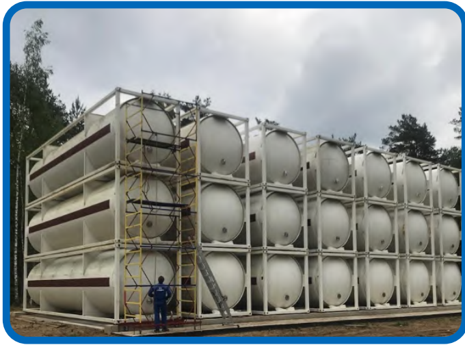
Рис. 4. Монтаж емкостей гелиевого газгольдера.
